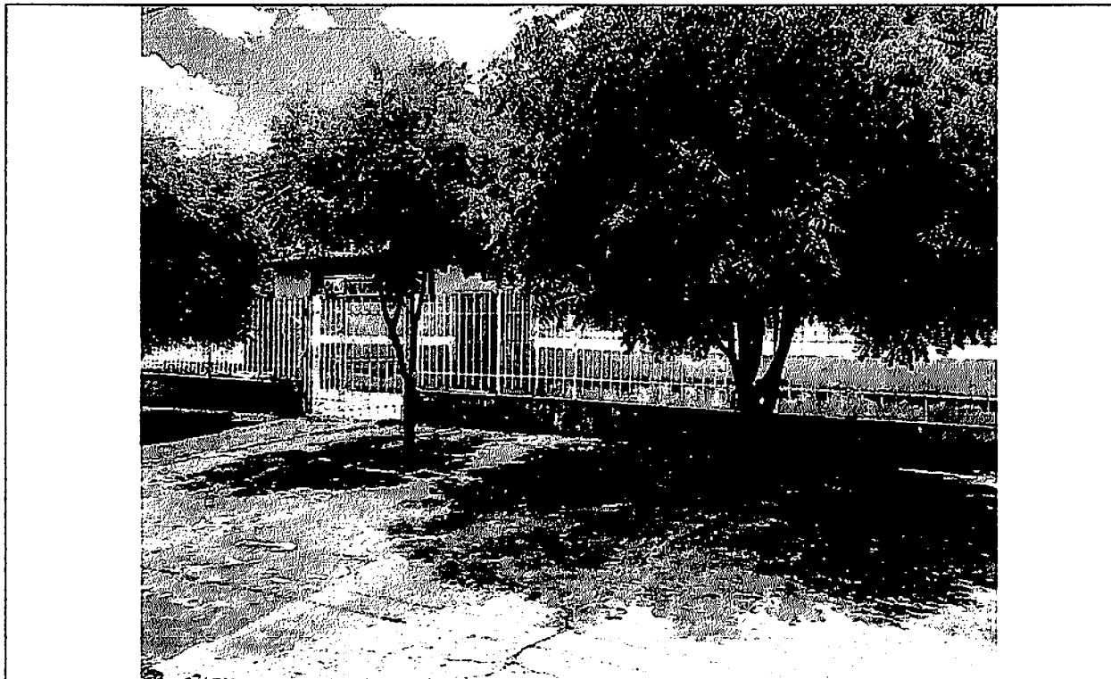
FOTO 01 – Fachada da Escola.
