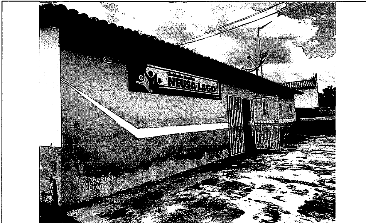
FOTO 03 – Fachada da Escola.
