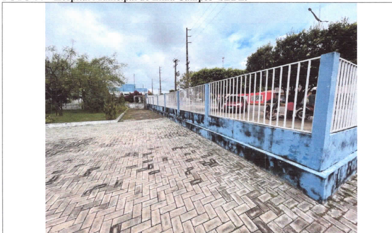
FOTO 04 – Hospital Municipal de Lima Campos- SEDE.
