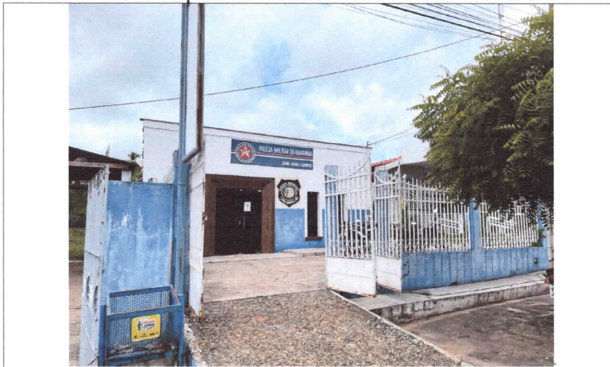
FOTO 15 – Guarda municipal- SEDE.
