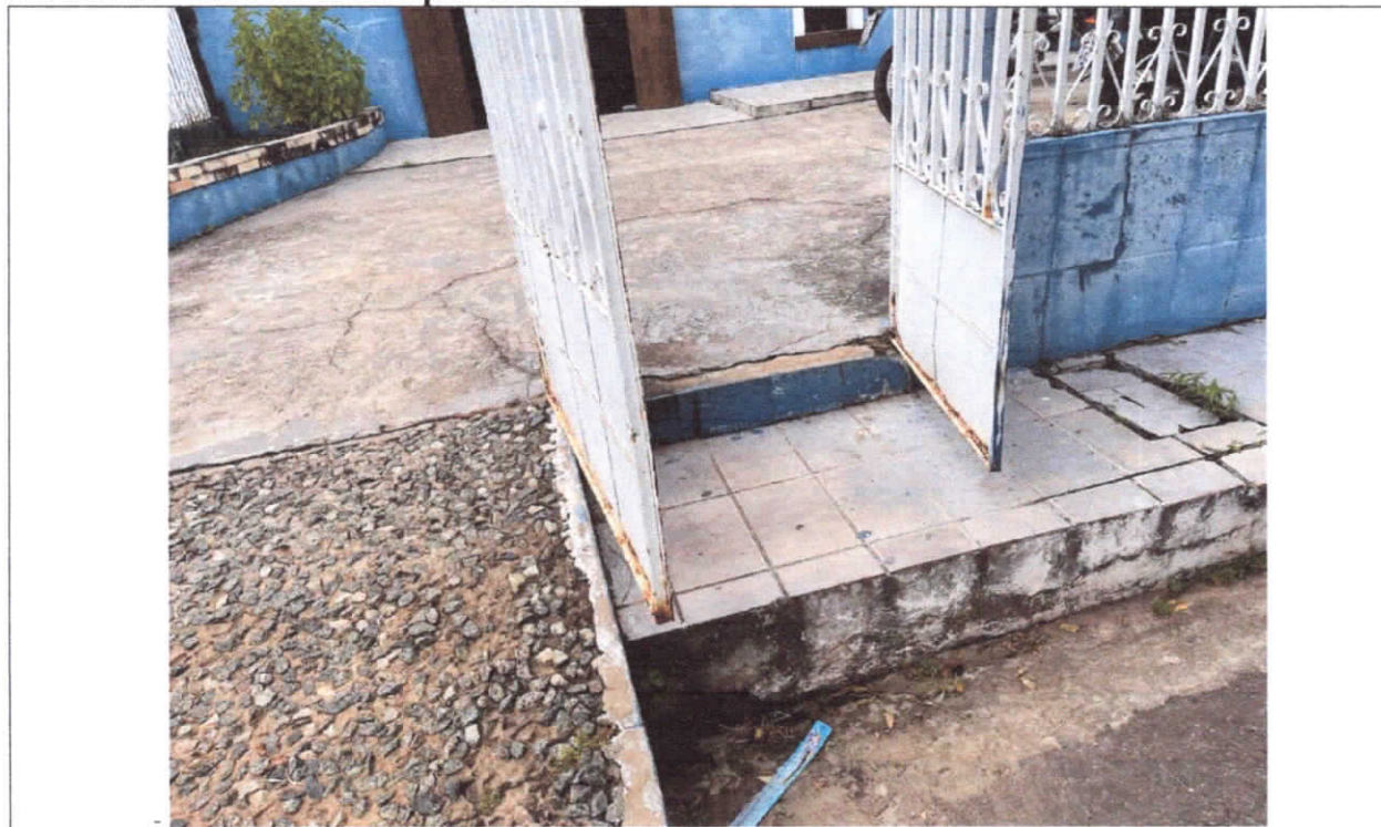
FOTO 16 – Guarda municipal- SEDE.
