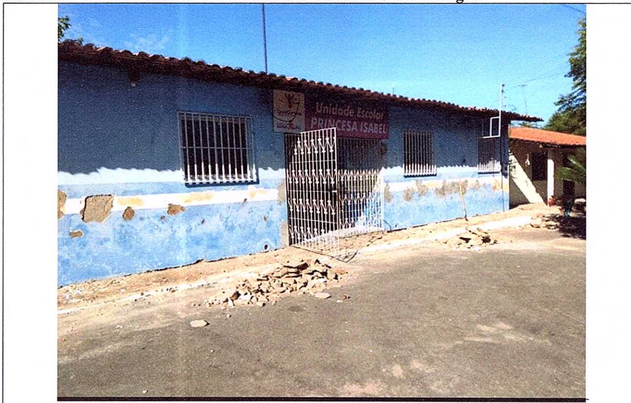
FOTO 24– Unidade Escolar Princesa Isabel- Povoado São Domingos.
