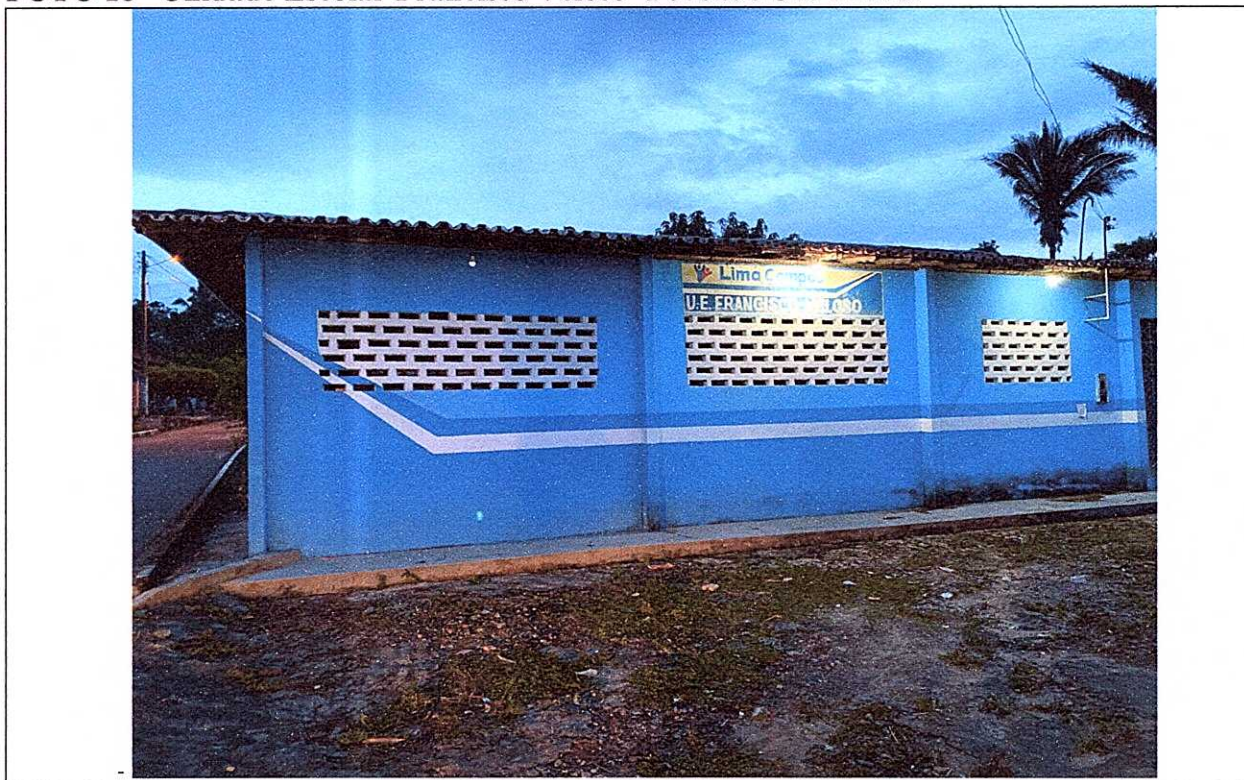
FOTO 18– Unidade Escolar Francisco Veloso- Povoado São Pedro.
