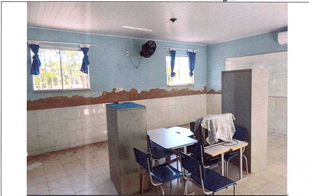
FOTO 25– Unidade Escolar Princesa Isabel- Povoado São Domingos.
