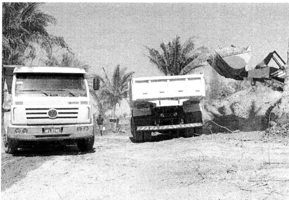
PIÇARRA DE JAZIDA PARA BASE DE PAVIMENTAÇÃO
